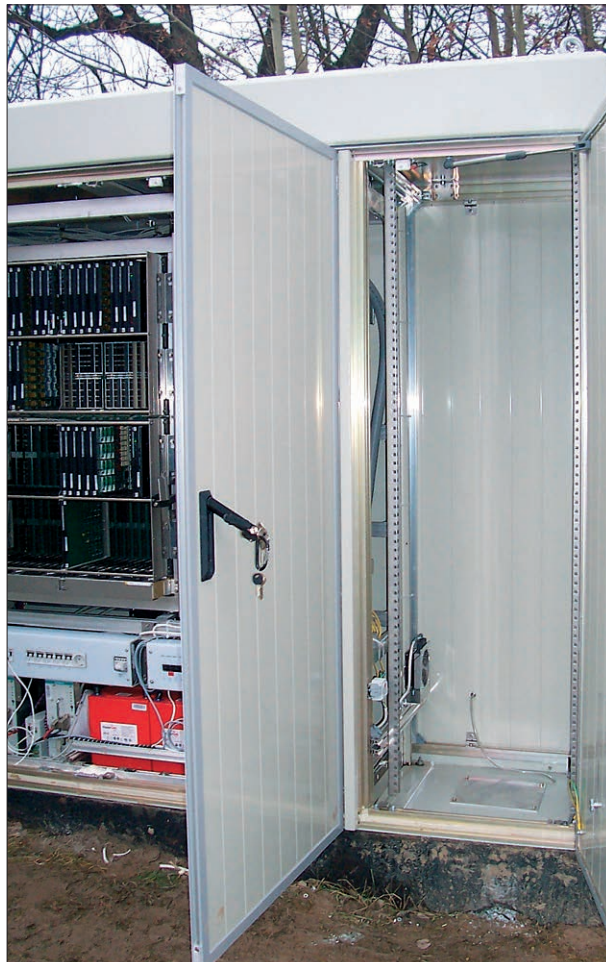
Schränk nach dem Ausbau
