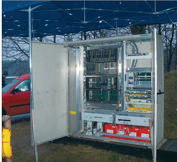
Schränk vor dem Ausbau
