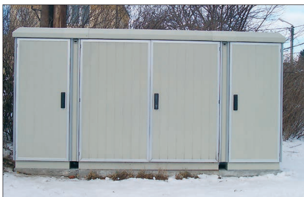
Schrank nach dem Ausbau
