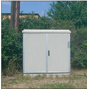
Schrank vor dem Ausbau
