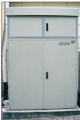
Schrank nach dem Ausbau
