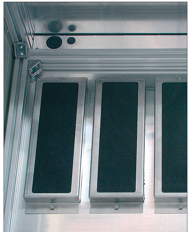
Mit Schaum gefüllte Durchführung
