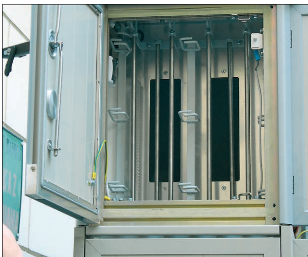
Schrank nach dem Ausbau
